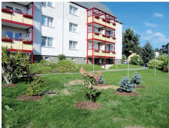
Bepflanzung Mozartstraße nach Balkonanbau
