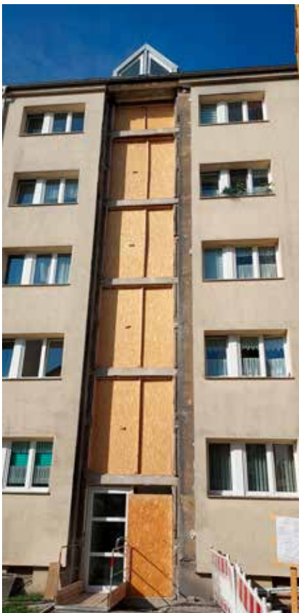
Elemente ausgebaut mit provisorischem Verschluss
