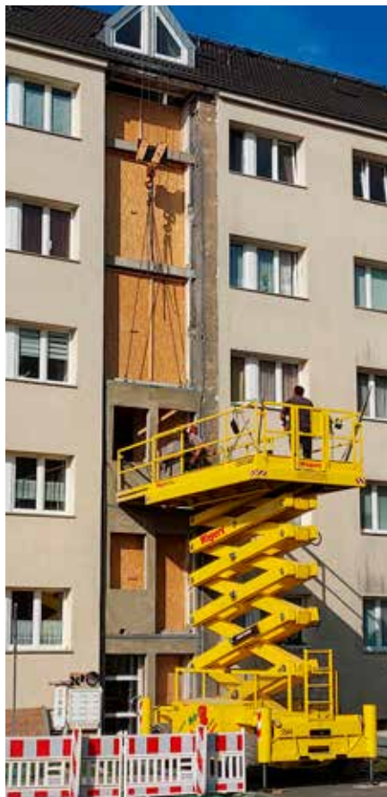
Einbau neue Elemente
