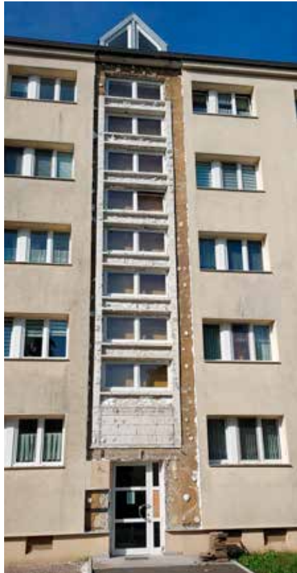
nach Abtrennung der Dämmung
