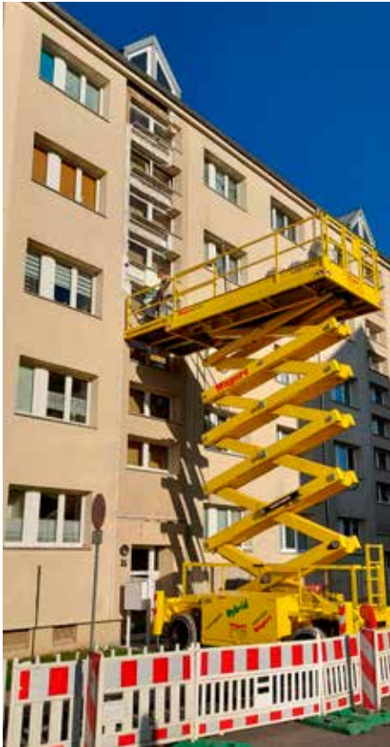
Abtrennung der Dämmung
