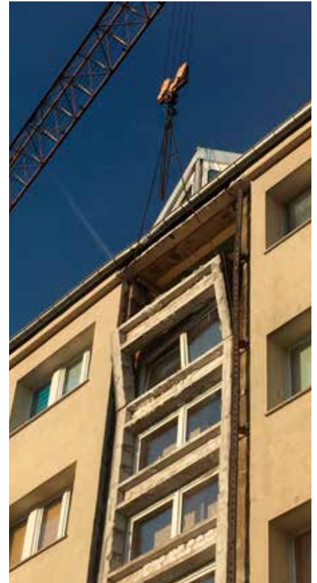
Herauslösung eines alten Elementes
