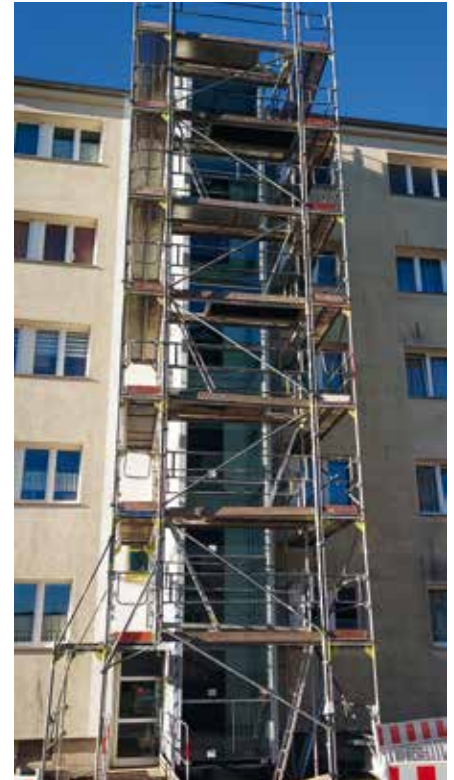
Aufzugsschacht angebaut
