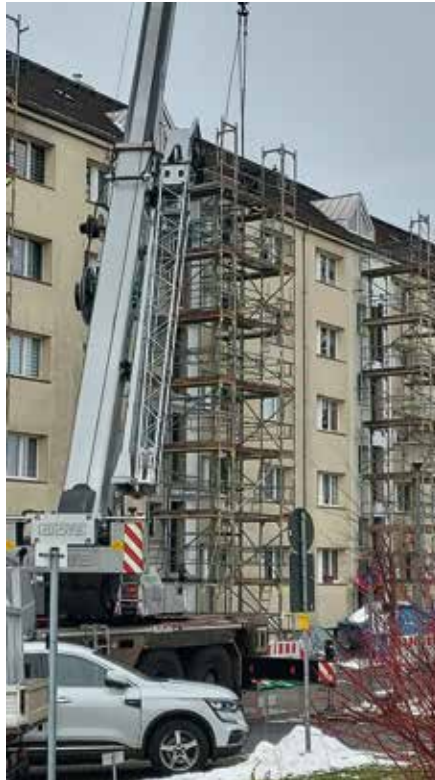
Aufbau des Schachtgerüsts
