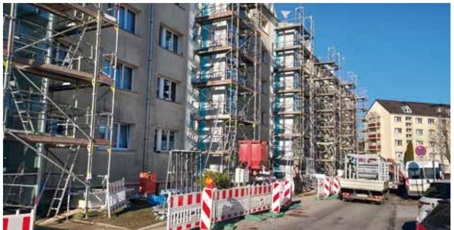
Blick auf die Montage der Aufzugsschächte
